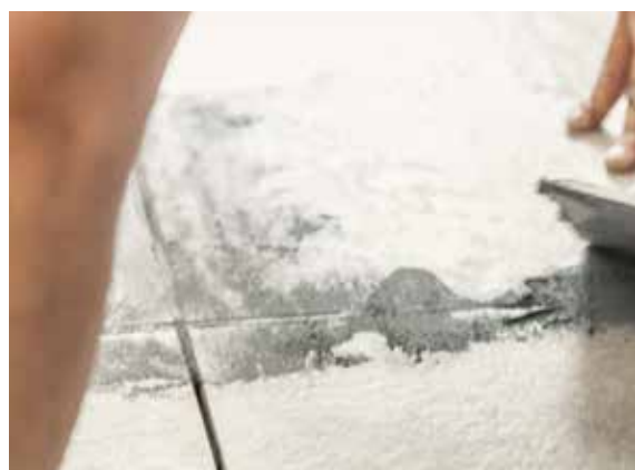
4 Voeg tegels in met het DryTile voegmiddel. Het is belangrijk om het voegmiddel en water in de juiste verhouding te mengen volgens de instructies van de fabrikant.
