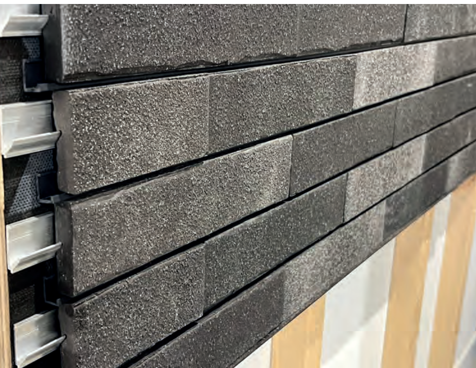
De steenstrips zijn voorzien van een zaagsnede aan de achterkant.
