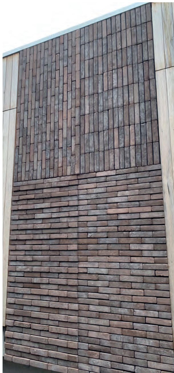
Diverse steenstripverbanden zijn mogelijk met het mechanische montagesysteem.
